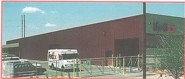
Şekil 2.1. Güneşle Isıtmalı (Solarwall) Federal Express Binası [39]
