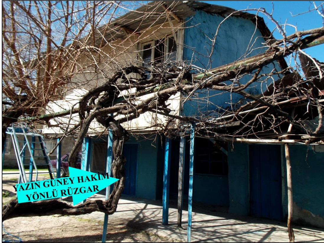
Foto 60: Küçük Kırım Mahallesinde Avlusu Güneye Bakan İki Katlı Kırımlı Evi
