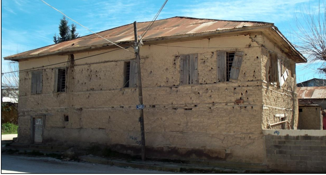
Foto 81: Bota Mahallesinde Kerpiç Bir Ev
