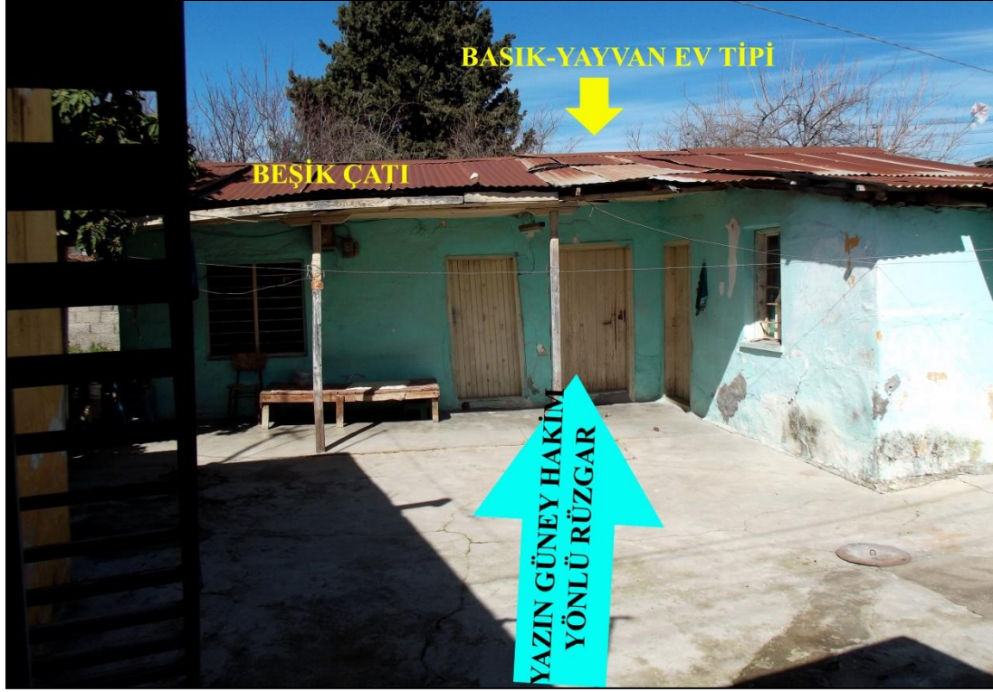
Foto 59: Küçük Kırım Mahallesinde Avlusu Güneye Bakan, Basık Tek Katlı Bir Kırımlı Evi
