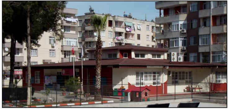
Foto 25: Hamidiye Anaokulunun Güney ve Doğu Cephesi
