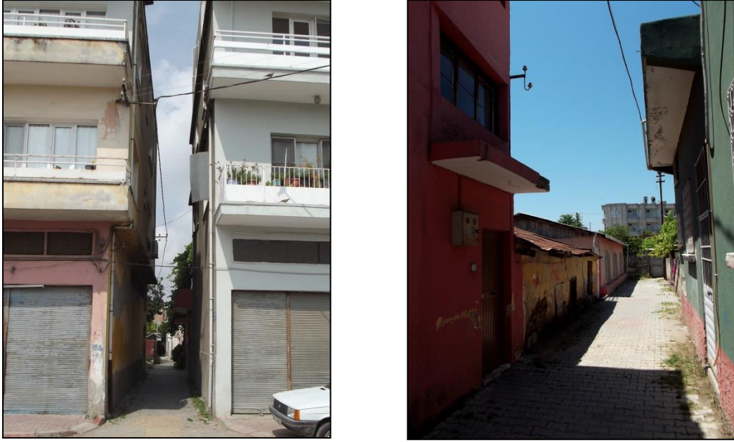
Foto 36: Muradiye Mahallesinde (Solda) Burhaniye Mahallesinde (Sağda) Çıkmaz Sokaklar
