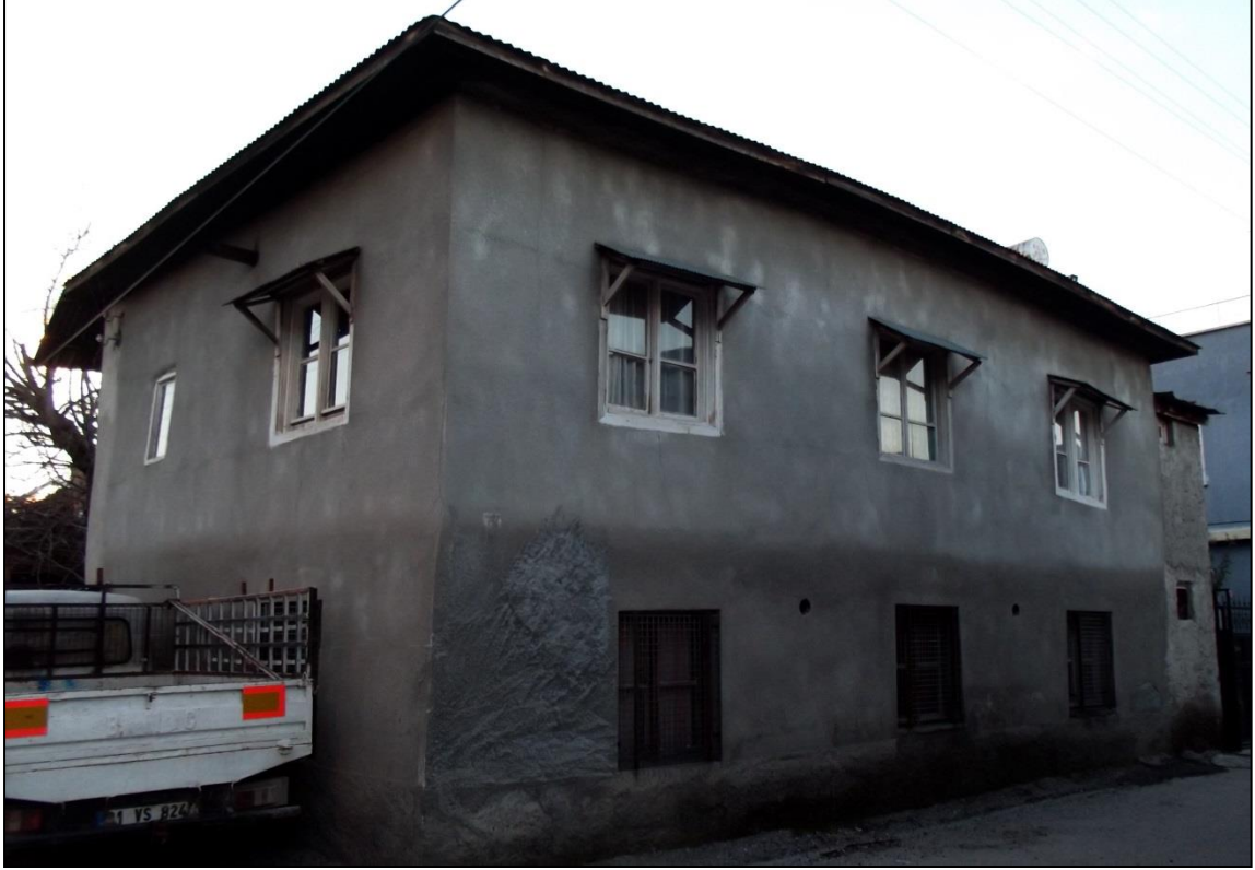
Foto 61: Kaltakiye Mahallesinde Avlusu Batıya Bakan, İki Katlı Kırımlı Evi
