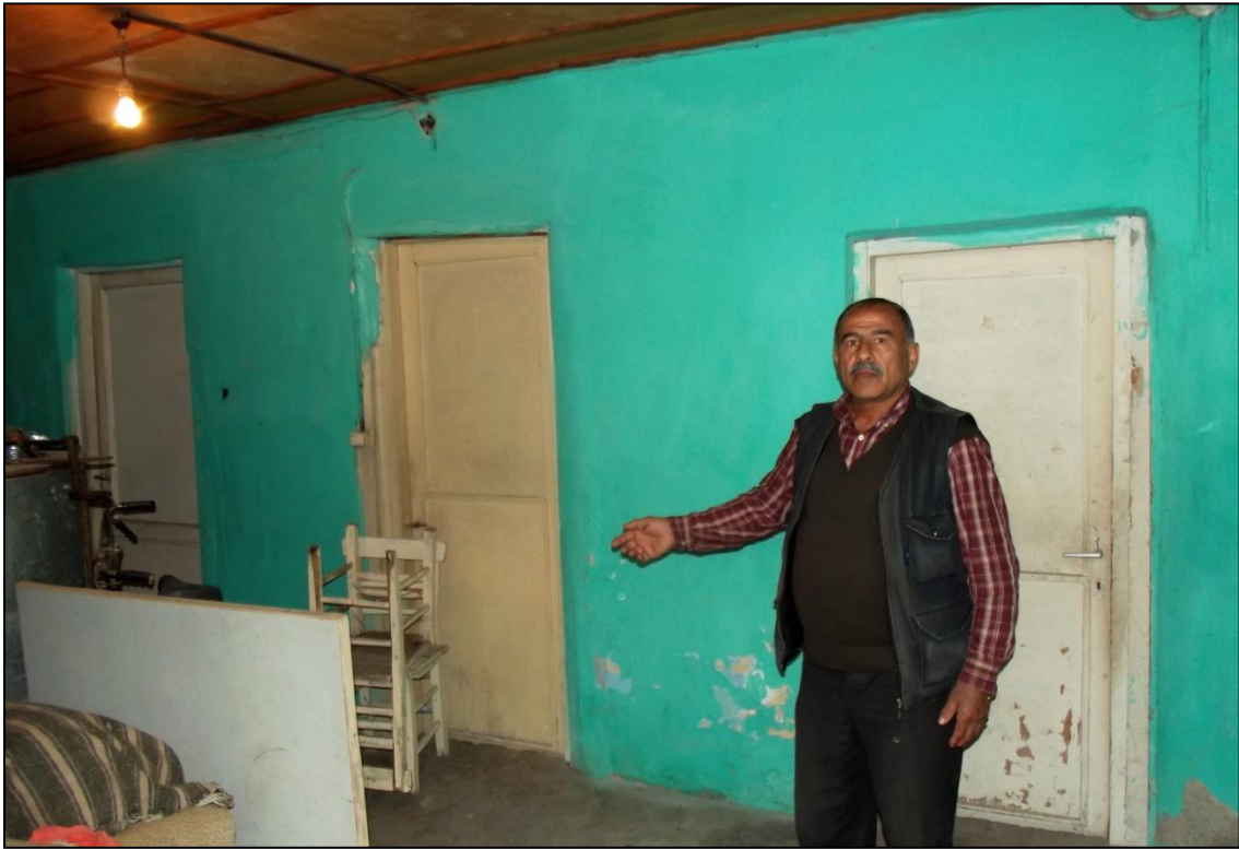
Foto 62: Kaltakiye Mahallesinde Avlusu Batıya Bakan Kırımlı Evinin Avludan Alt Katına Bakış
