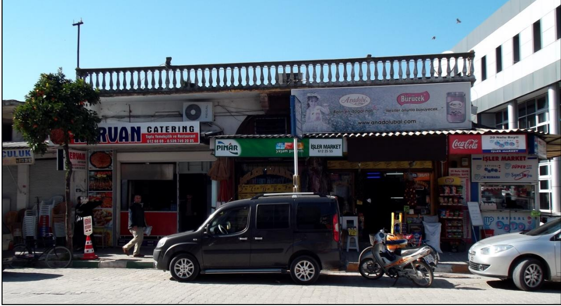
Foto 22: 1998 Ceyhan Depreminde Üst Katları Yıkılan, Günümüzdeki Eski Kaymakamlık Binası
