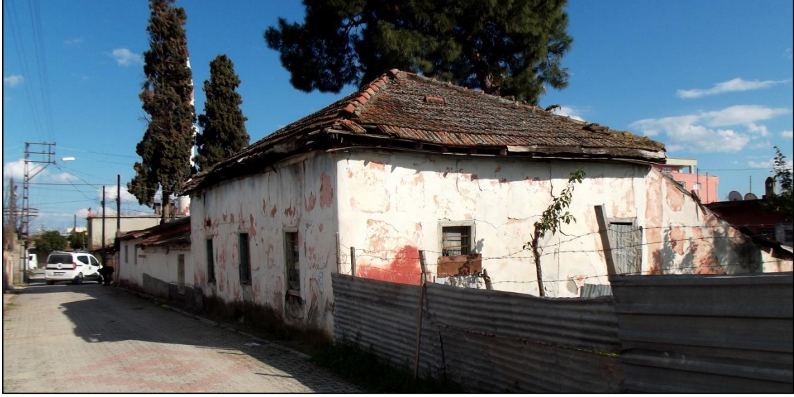
Foto 105: Civantayak Mahallesinde Avlulu, Merkezi Çatı Sistemli, Çatısı Tuğla Örülü Eski Bir Mesken
