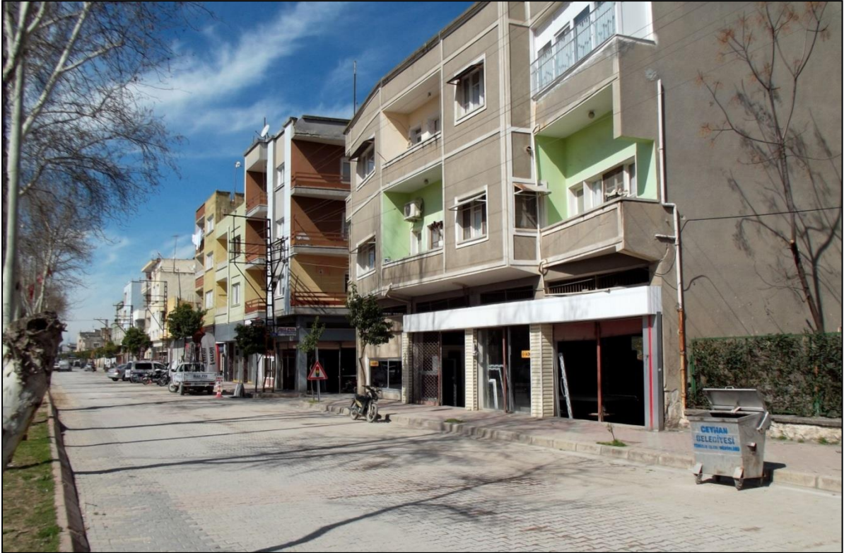
Foto 104: Hürriyet Mahallesi'nde Güney Cepheli Bitişik Nizamda Meskenler
