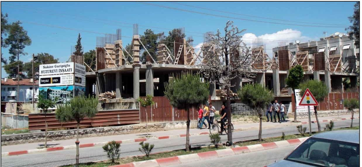
Foto 117: Burhaniye Mahallesindeki Sakine Garipoğlu Huzurevi İnşaatı
