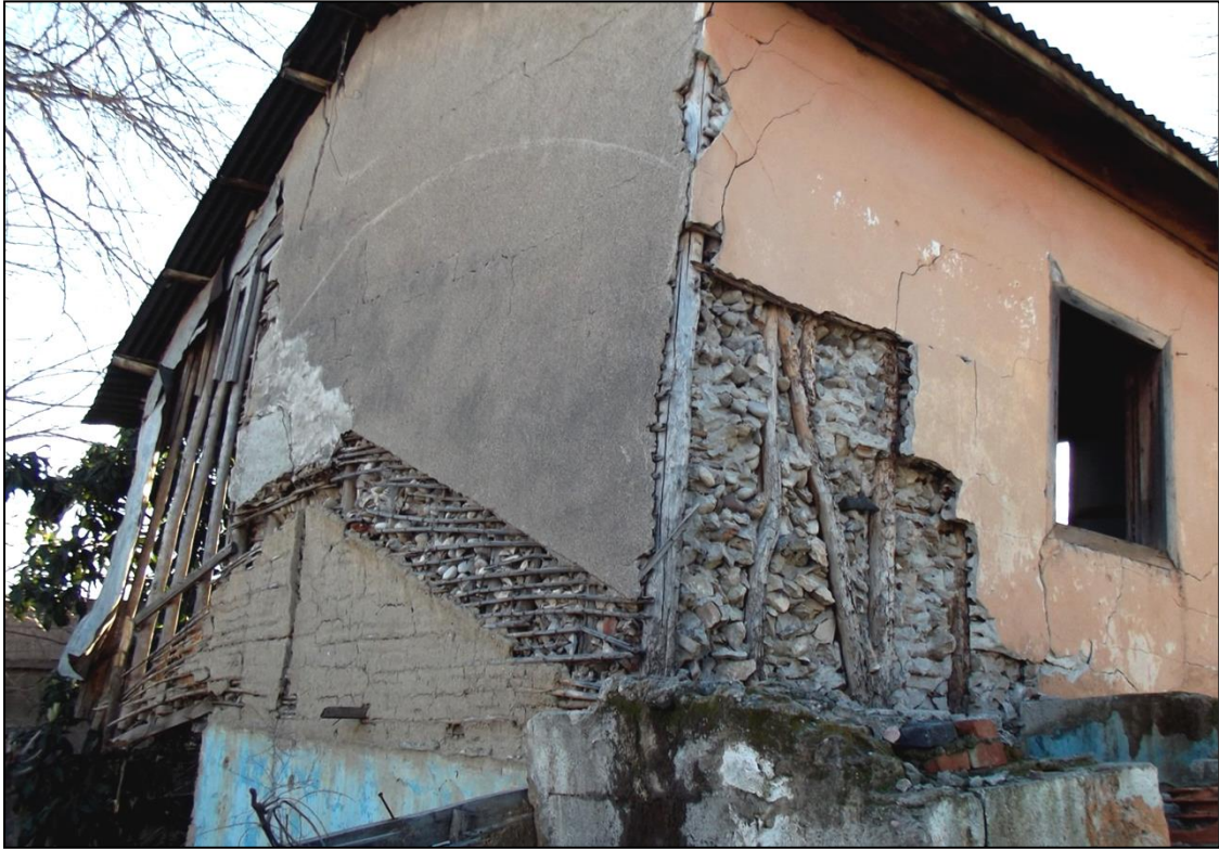
Foto 17: Muradiye Mahallesiinde Duvarları Kamışlardan Yapılmış Dolgu Malzemesi Toprak ve Taştan Olan Dolma Bir Ev
