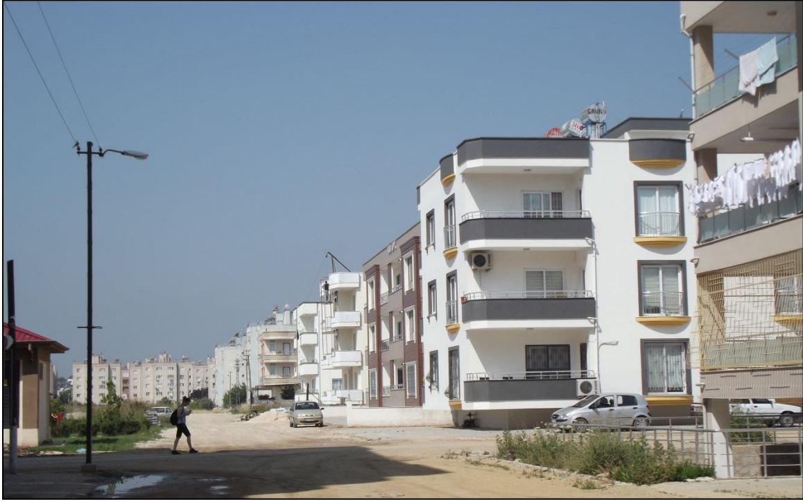
Foto 78: Namık Kemal Mahallesi'nin Güneyinde Yeni Lüks Apartmanlar
