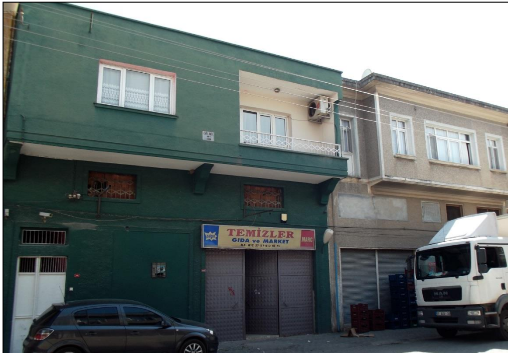
Foto 100: Kaltakiye Mahallesinde Cumbalı Betonarme Depolu Ev
