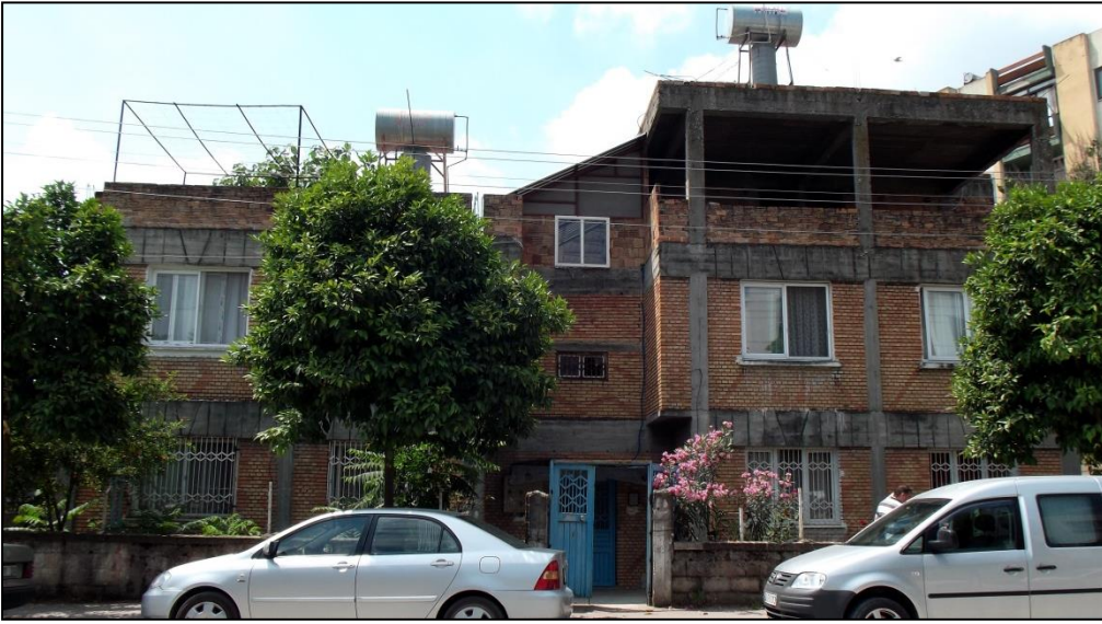
Foto 89: Ulus Mahallesiinde Sıvasız Tuğla Ev
