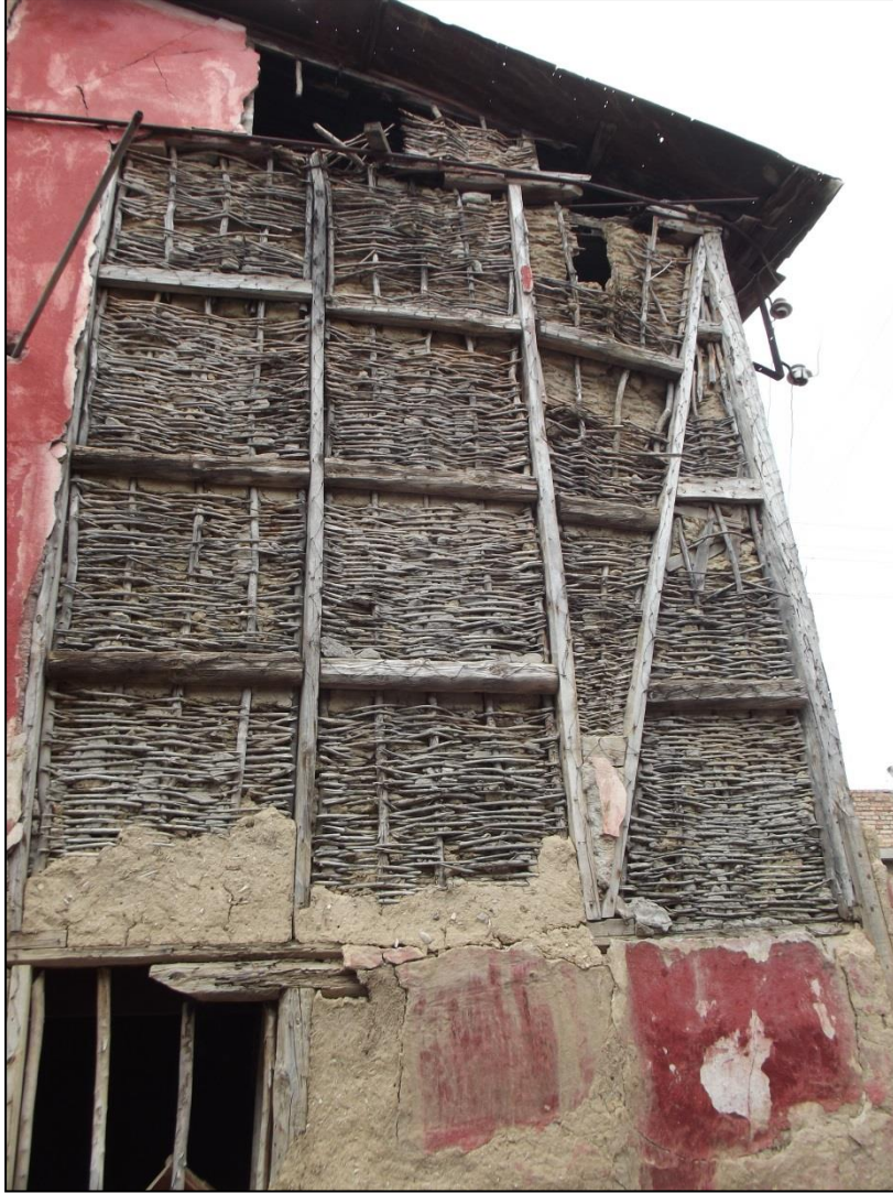
Foto 79: Muradiye Mahallesi'nde Toprakla Bitkisel Malzemenin Kullanıldığı Örme Ev
