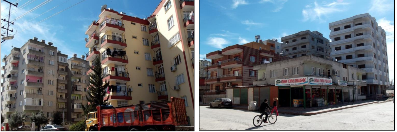
Foto 44: İstiklal Mahallesi Sakine Garipoğlu İlkokulunun Batı (Solda) Cephesi ve Kapalı Spor Salonunun Doğu (Sağda) Cephesi
