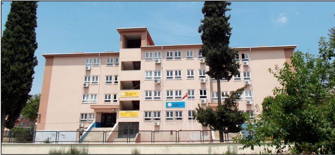
Foto 122: Ulus Mahallesi'ndeki Arif Nihat Asya Ortaokulu
