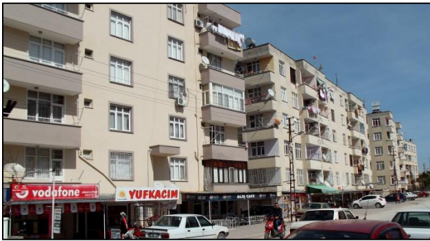
Foto 24: Pamukeli İlkokulu Kuzey Cephesi
