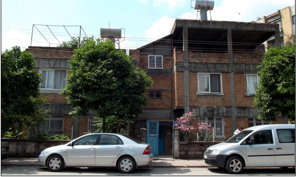
Foto 71: Hürriyet Mahallesi Betonarme Düz Damlı Bahçeli Bir Ev
