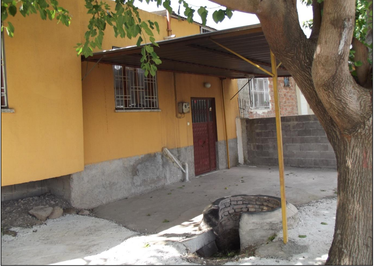
Foto 74: Emek Mahallesiinde Bahe İinde Ocak
