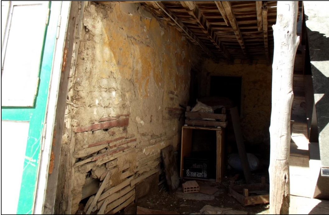
Foto 82: Bota Mahallesindeki Kerpiç Evin İç Duvarı
