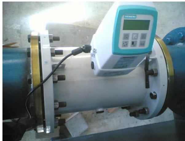
Şekil 4.6. Giriş debisini ölçen elektromanyetik debimetre
