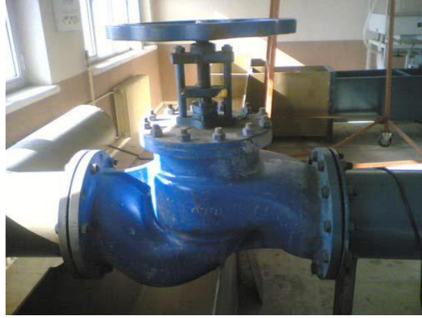
Şekil 4.7. Giriş debisinin ayarlandığı debimetrenin ön kısmındaki vana
