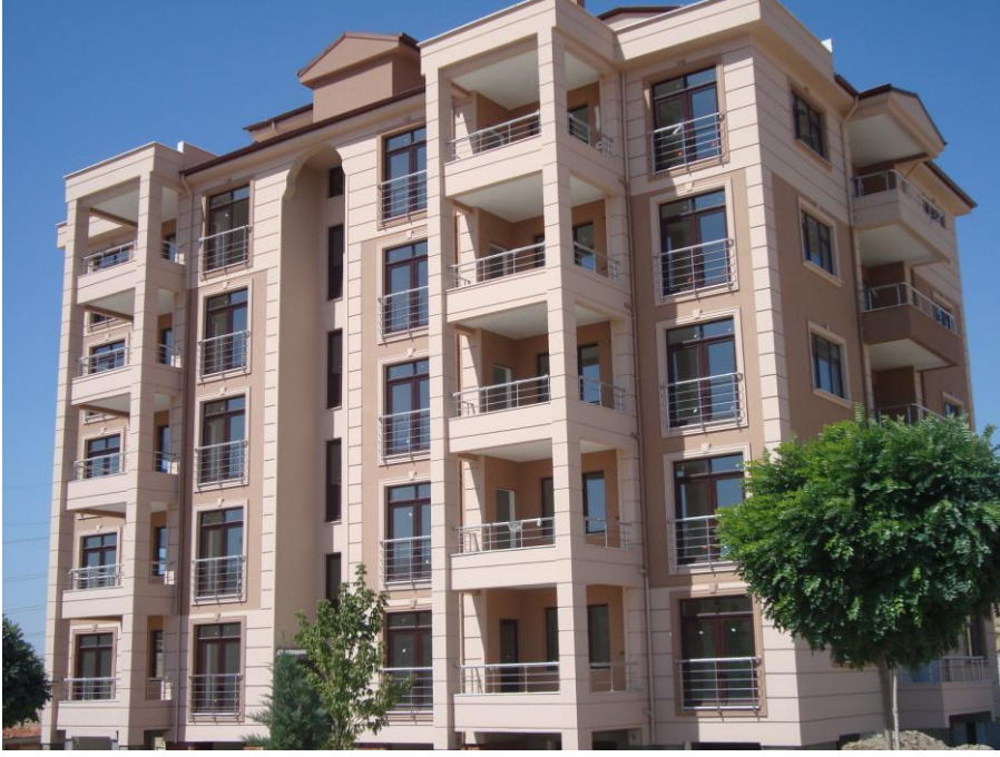
Resim 4.31. Söve ve yalı baskı tekniğinin binaya uygulanmış hali (Hilalkentmahallesi/Elazığ).
