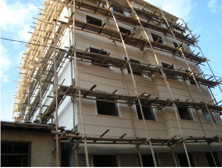
Resim 4.30. Söve ve yalı baskı tekniğinin binaya uygulama aşaması (Üniversite mahallesi/Elazığ).
