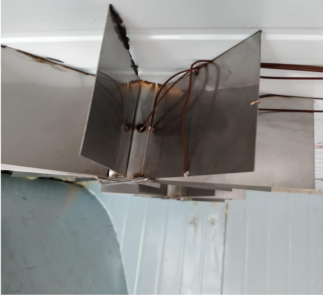
Şekil 2.17. Isı borusunun kanadına yerleştirilmiş ısı çiftler
