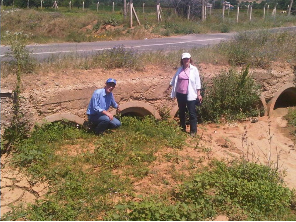
Şekil 3.5. Behremaz Deresi besleme kanalı içerisinde meydana gelen siltlenme (Koordinat:546012 - 4260453).
