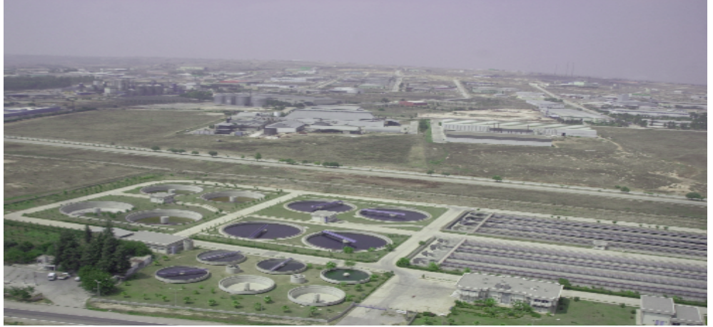
Fotoğraf 7: Adana Hacı Sabancı Organize Sanayi Bölgesi Arıtma Tesisi
