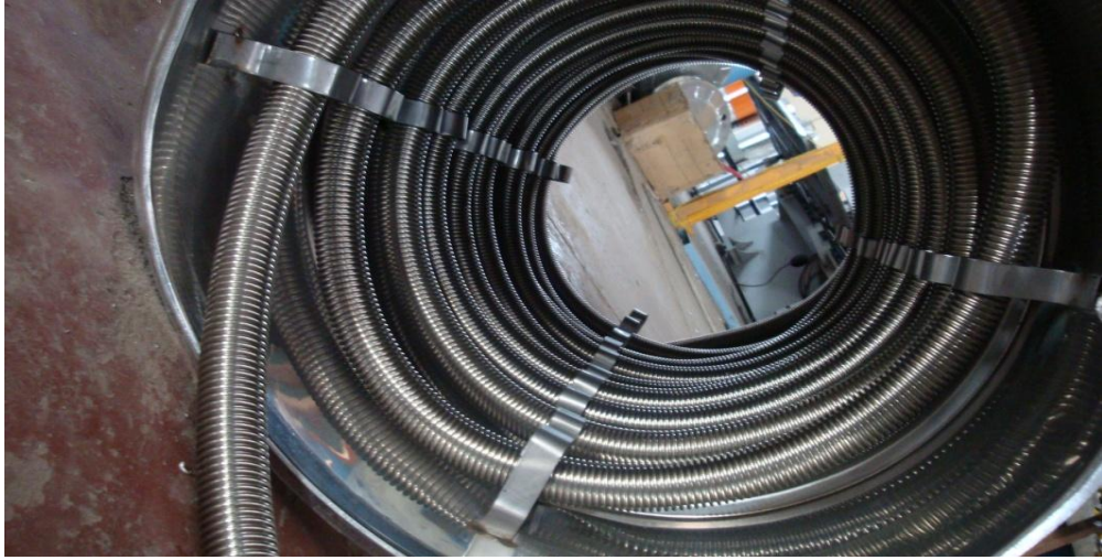
Şekil 2.4. Spiral boru yerleştirilmiş düşey sıcak su tankının içten görünüşü.
