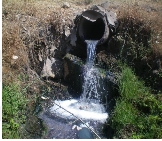
Şekil 3.5. Boya fabrikası atık suları (4. İstasyon)
