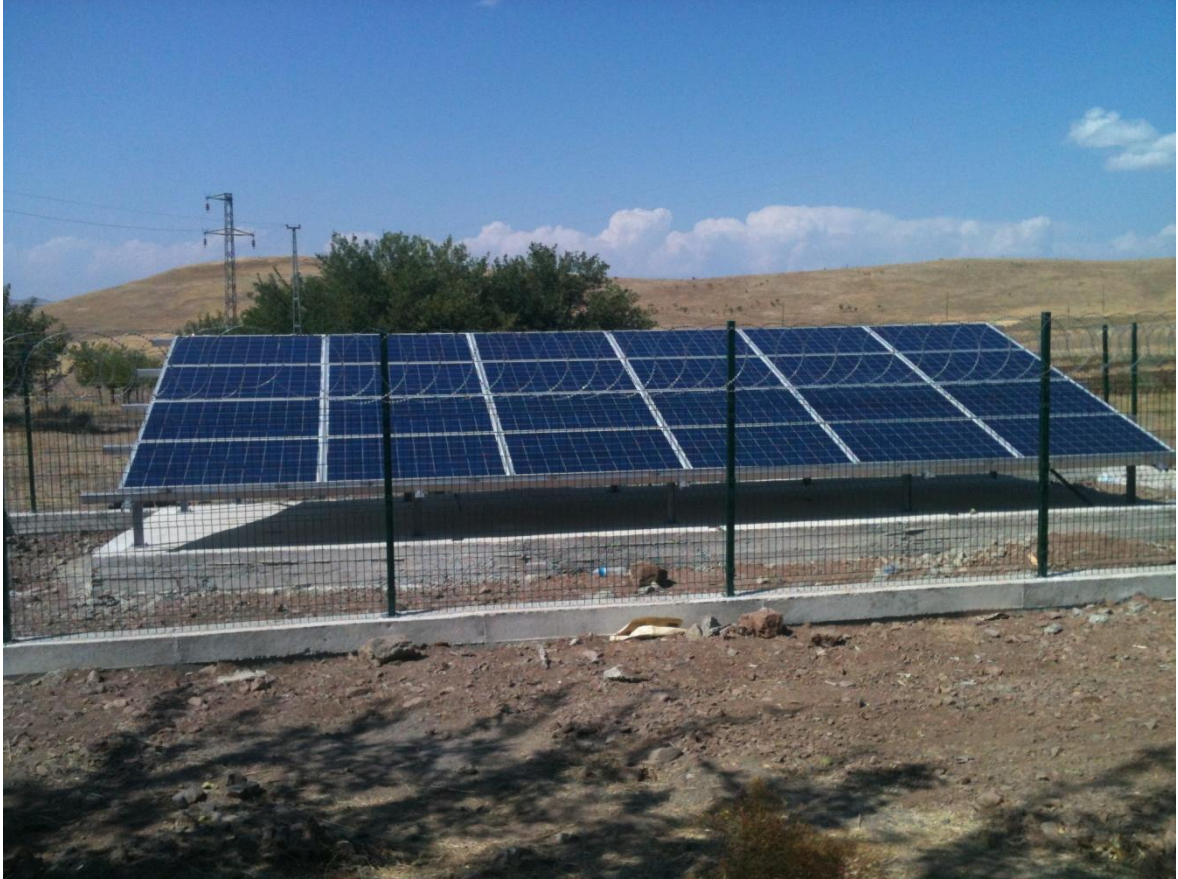
Şekil 5.2. 24 adet 240 W'lık fotovoltaik paneller
