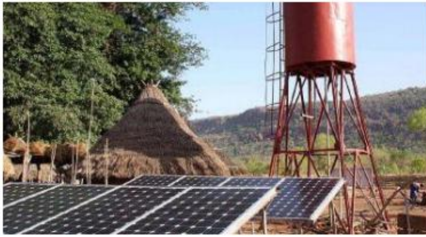
Şekil 3.5. Fotovoltaik destekli ve depolu su pompalama sistemi [31]
