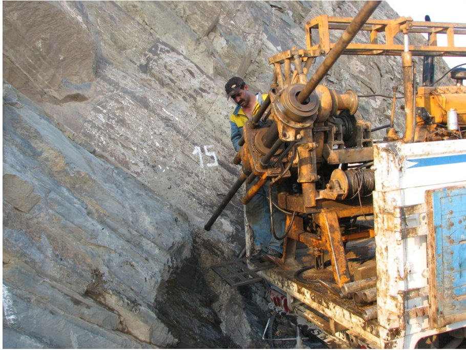
Şekil 4.9. Silttaşlarında 40^\circ 'lik jeoteknik amaçlı sondajın yapılması (Bakış yönü KD)
