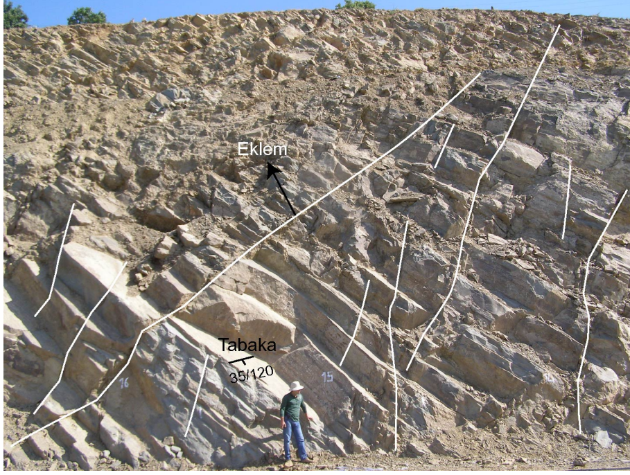
Şekil 3.11. Silttaşlarında gelişmiş tabaka ve eklem görünümü. Bakış yönü G'den K'ye doğru.
